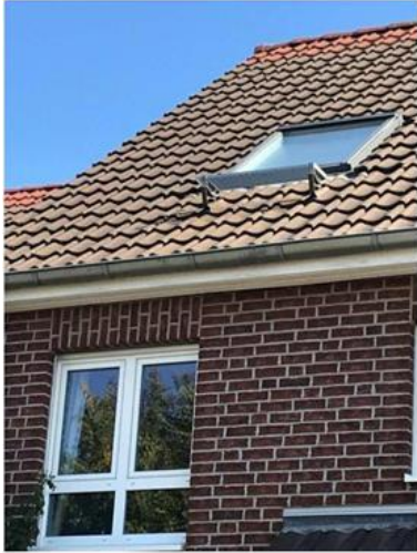
Abbildung 8: Austritt mit einer Stufe.
