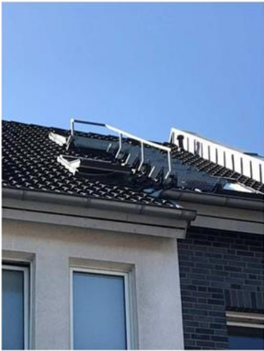
Abbildung 10: Austritt mit mehr als zwei Stufen und Festhaltungsmöglichkeit
