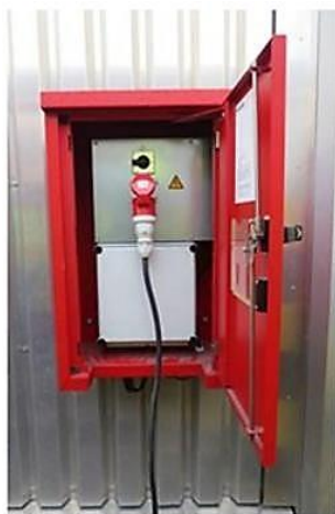
Abbildung 7: Schutzschrank
