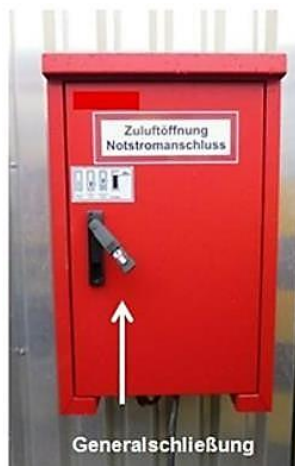
Abbildung 8: Noteinspeisung
