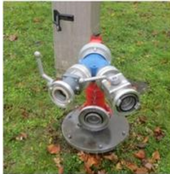
Abbildung 4: Sammelstück mit 2B-Absperrventilen
