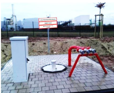
Abbildung 2: Exemplarische Ausführung eines Bedienschrank und eines Brunnens mit einer Leistung von circa 1600 l/min
