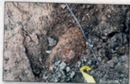
Über den hier noch in der Erde liegenden Blindgänger war offenbar irgendwann ein Stromkabel verlegt worden. Fotos: Stadt Monheim am Rhein
