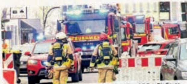
Bei Kanalbauarbeiten hat ein Bagger eine Gasleitung beschädigt. Die Feuerwehr hat die angrenzenden Häuser überprüft. BSP-FOTO: PATRICK SCHÜLLER
